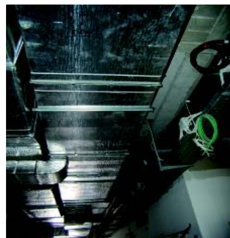
Vzduchové kanály izolované TROCELLEN DUCT CL1 ALU
